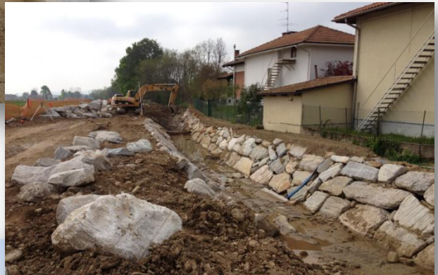
SISTEMAZIONE TRATTO A VALLE DEL PONTE DI VIA TRENTO
