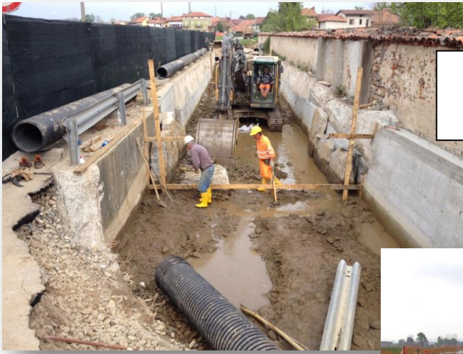
VIA MAZZINI – RIPRISTINO SCOGLIERE A MONTE DEL PONTE DI VIA ROMA
