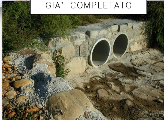
CANALE DI GRONDA GIÀ COMPLETATO
